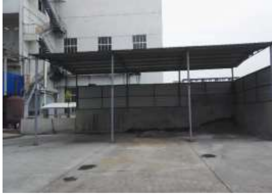
升缓冲渣场防风围挡、防雨顶棚
